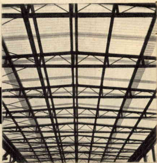
Fig. 9 - Esempio di utilizzazione di lastre di laminato plastico ondulato traslucido nella costruzione di una grande e luminosa tettoia a spioventi.
