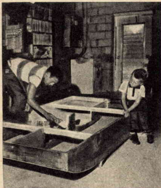
Fig. 8 - La verniciatura interna dello scafo si esegue prima della sistemazione dei sedili sui regoli di sostegno. A un primo strato di fondo in cementite, faranno seguito due mani di smalto di buona qualità.
